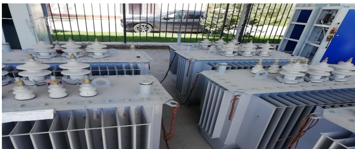
Трансформатор ТМ-250/10/0,4кВ
