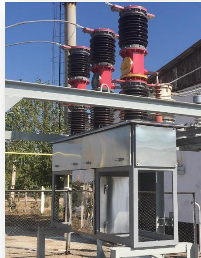
Ячейки КРН -3 с вакуумными выключателями
