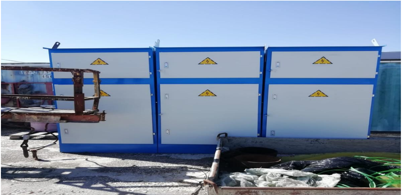
Ячейки КРН -3 с вакуумными выключателями
