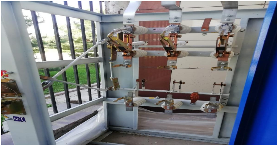
Ячейка КСО-306 с ВНА -10 кВ вводная
