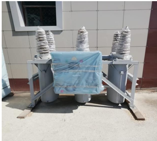
Вакуумный выключатель -35 кВ
