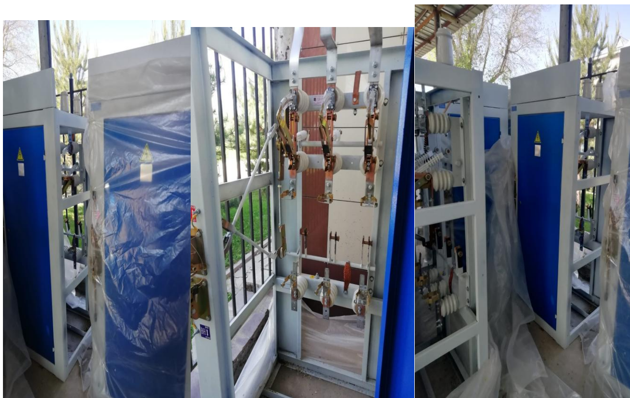
Ячейка КСО-306 с ВНА-10 вводная и линейная
